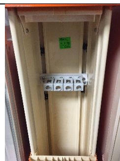
Bornier (avec les 4 bornes) monté dans la borne avec hauteur de porte de 500 mm
